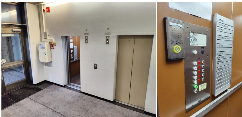
Kuva 35. Hissiaula katutasokerroksessa. Vaalea värimaailma toistuu myös rakennuksen sisätiloissa. Kuva 36. (oik.) Tarkempi kuva hissien varusteista. Hissi on Koneen valmistama ja siinä on vuosiluku 1981.
