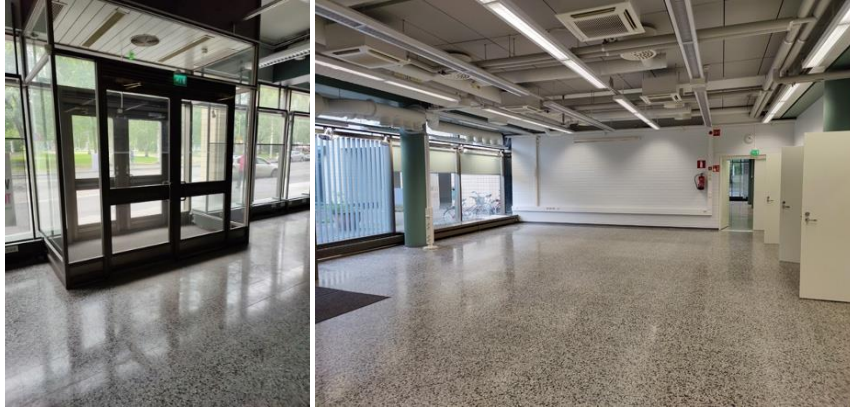
Kuva 37. (vas.) Myymälätilan tuulikaappi. Kirkkokuisto näkyy kauniisti rakennuksen sisätiloihin. Kuva 38. (oik.) Sisäpihan ympärillä sijaitseva myymälätila/liiketila. Lattia on mosaiikkibetonia ja seinät valkoiseksi maalattua tiiliverhousa. Valaisimet ovat ripustettuja ja nauhamaisia.
